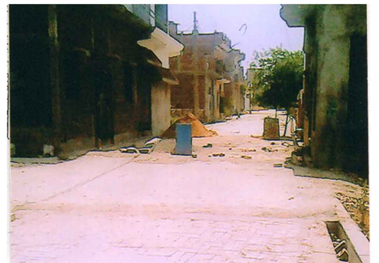
कचौरा रोड पर इन्टर लॉकिंग का कार्य।
